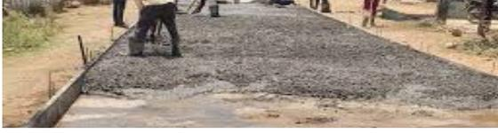
की लगभग 800 किमी सड़क को सीमेंट कंक्रीट करने का ठेका दो चरणों में दिया। सीमेंट कंक्रीट के चल रहे कामों में खराब गुणवत्ता के कारण दरारें आ गईं।
